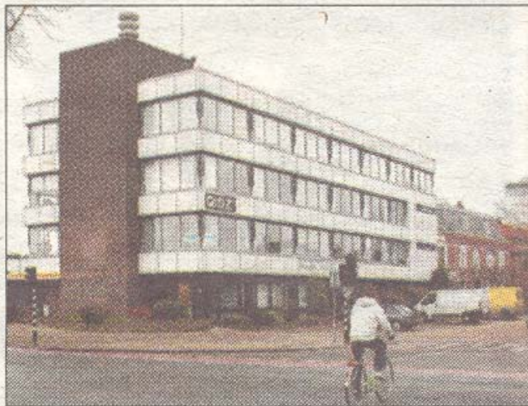
De Rabobank op de hoek van de Eerste Stationsstraat. ARCHIEFFOTO
